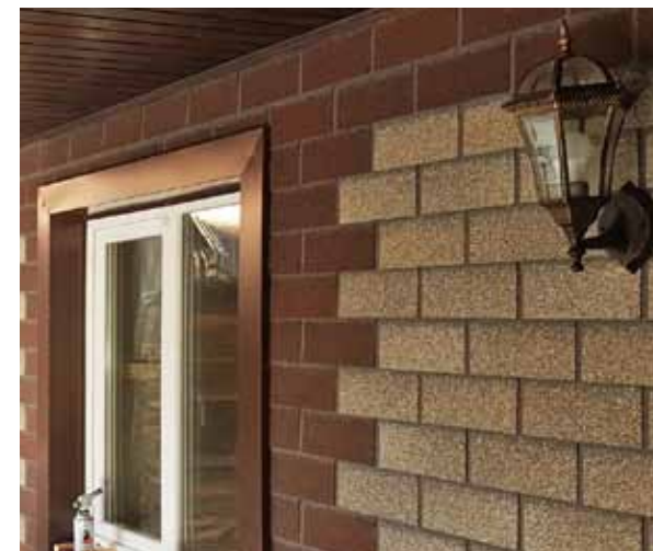
Рис. 3. Оформление оконных проемов
