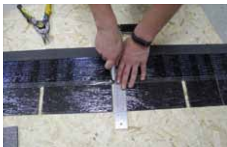
Рис. 6. Деление плитки на лепестки
