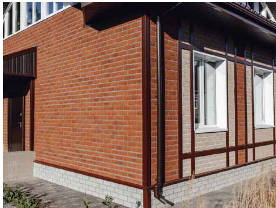
Рис. 1. Оформление фасада и цоколя
